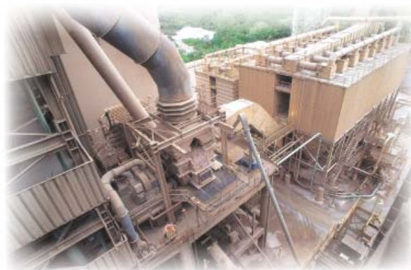
Ventilador de tiro inducido (ID) en una planta de cemento
