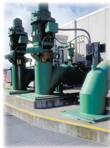
Sala de bombas
