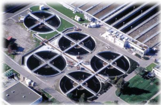
Planta de tratamiento de aguas
